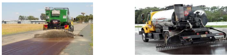
Рис. 1.1. Пропитка бетонного покрытия
